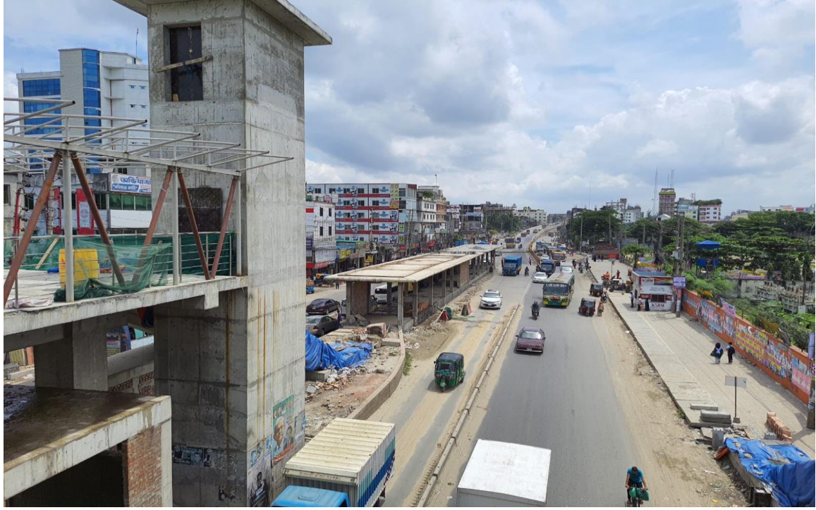
বিআরটি স্টেশন নির্মাণের কাজ চলমান
