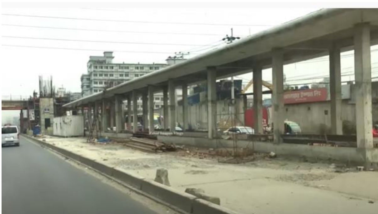
বিআরটি স্টেশন নির্মাণের কাজ চলমান
